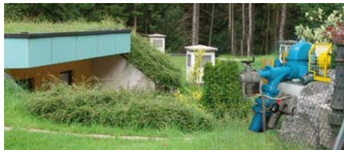
Das neue Trinkwasserkraftwerk im Bereich des Hochbehälters, hier im Bild ohne Einhausung.
